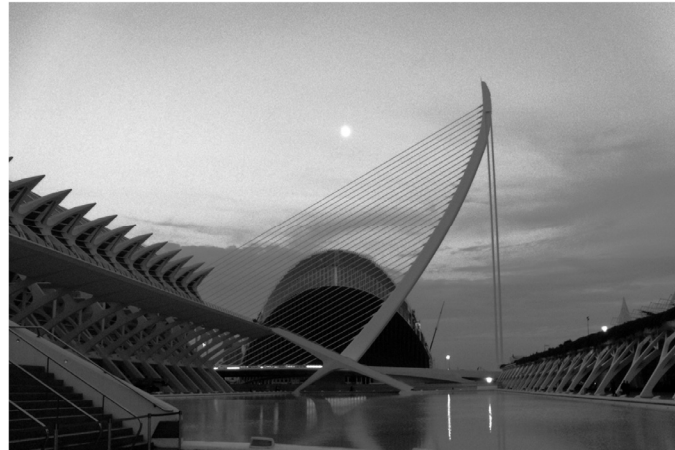
Santiago Calatrava - Serreria Bridge - Valencia 2008
